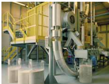
Die CCM-Mischung steuert sehr exakt die benötigten Komponentenmengen für die Reifenfertigung und verkürzt den Mischungsprozess von 24 auf etwa 5 Stunden
